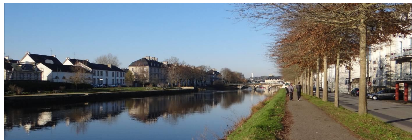
Photo 35 : Canal de Nantes à Brest à Pontivy (Source : BE Jacquelin et Chatillon)
